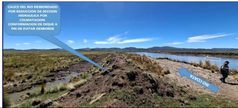
FIGURA 1 y 2 : TRAMO CRÍTICO EN EL RÍO COATA, EN EL SECTOR QUETEQUETE, DISTRITO DE COATA, PROVINCIA DE PUNO - PUNO. NOTESE, LA CONFORMACION DEL DIQUE FUSIBLE CONSTRUÍDO EN LA MARGEN IZQUIERDA EN PLENAS PRECIPITACIONES PLUVIALES, A FIN DE EVITAR EL DESBORDE DEL RÍO COATA, EL CUAL FUNCIONO CORRECTAMENTE.
